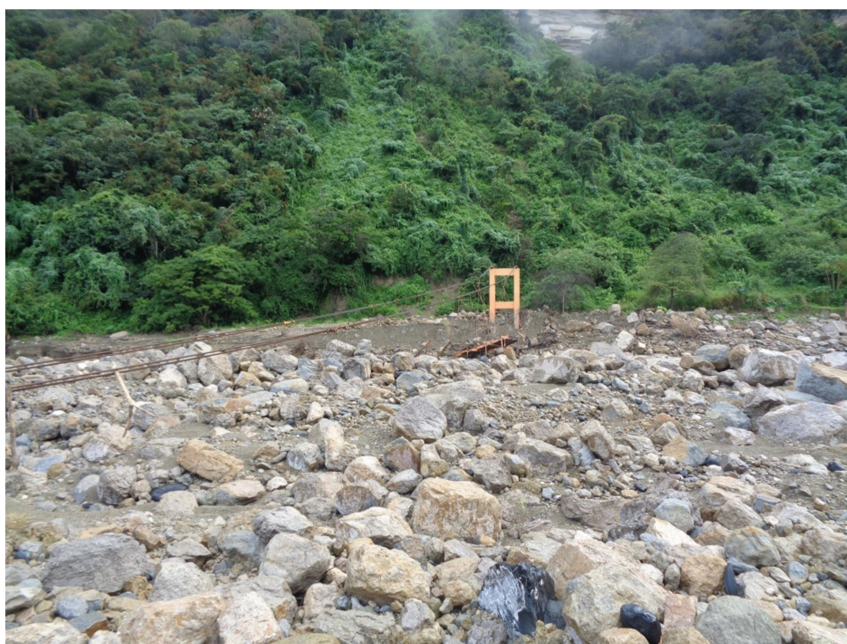
Obr. 3 Zničení mostu akumulací materiálu.
