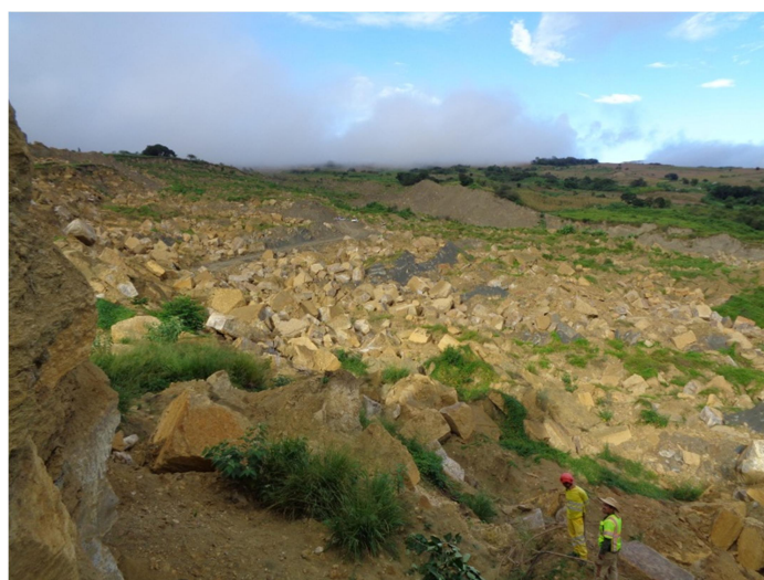
Obr. 5 Bloky porušených vápenců v místě sesuvu.
