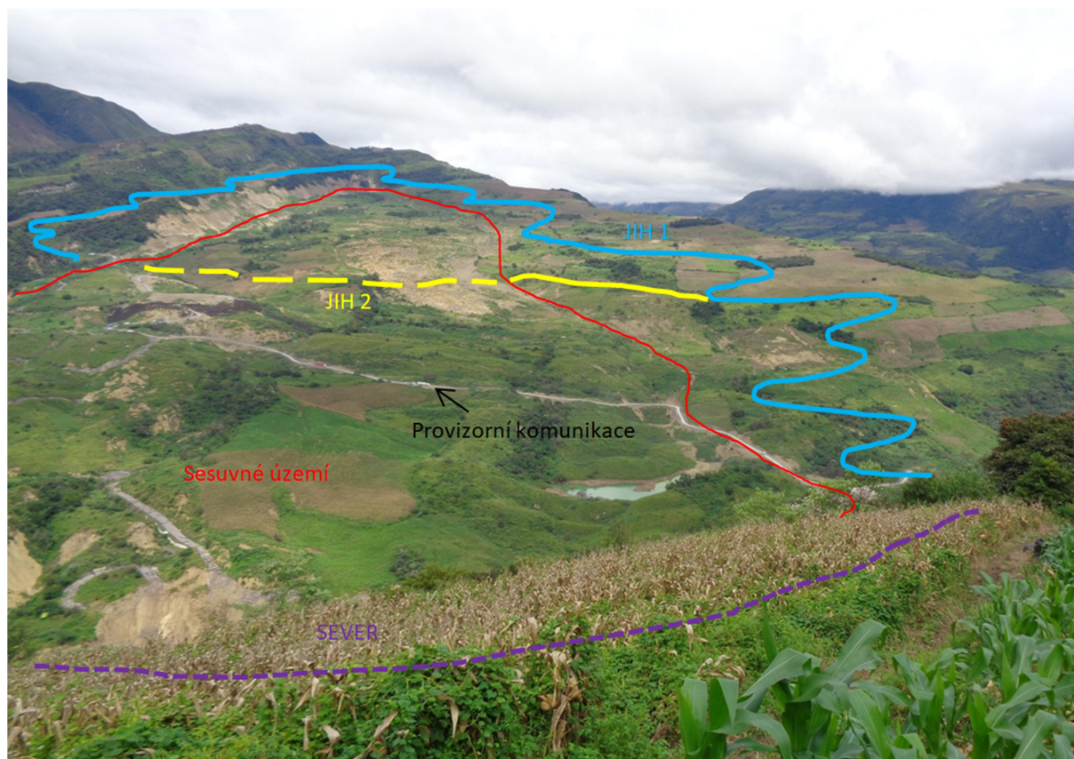
Obr. 6 Celkový pohled na stavební jámu situovanou v sesuvu.
